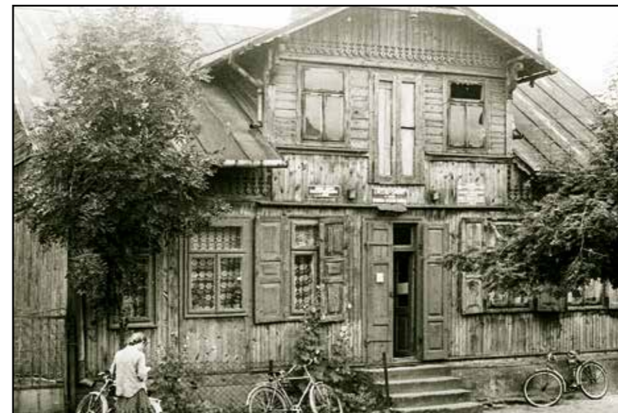
■ Budynek drewniany w Nurze, ul. Brokowska 1, wybudowany w latach 20-tych XX w. - w latach 70-tych siedziba Urzędu Gminy
