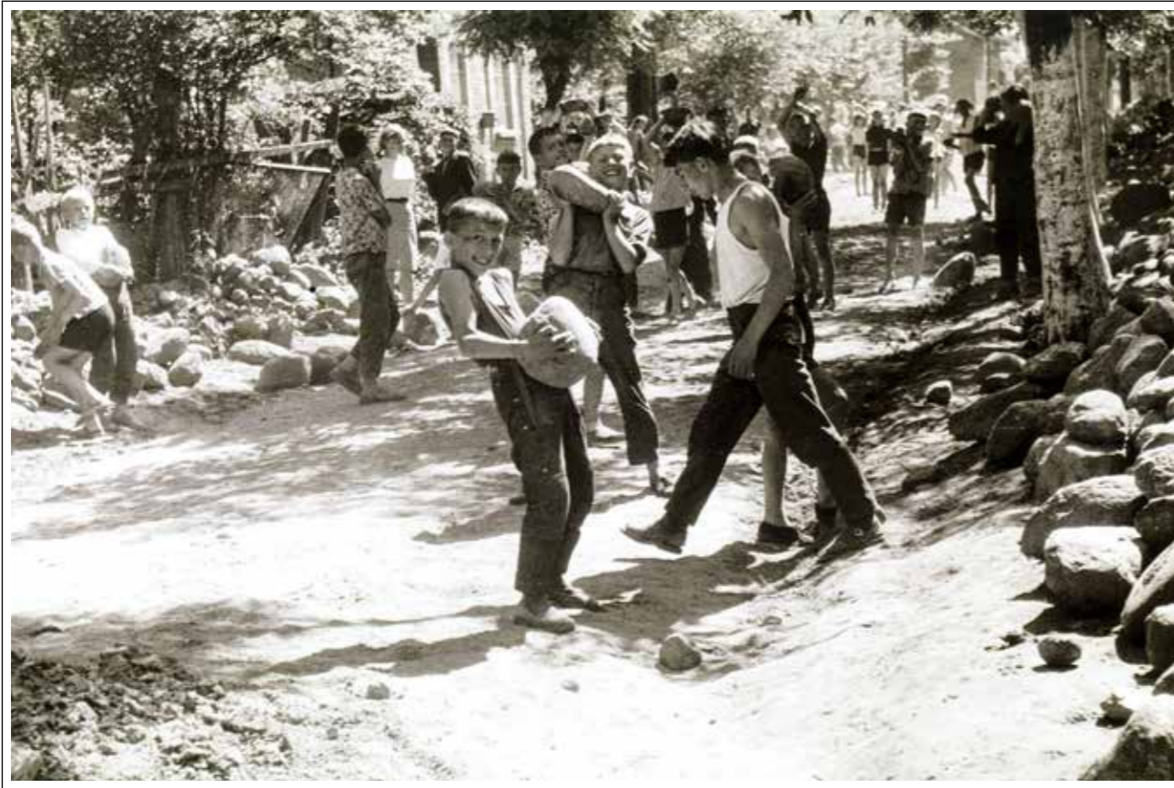
■ Budowa chodnika na Rynku w Nurze. Czyn społeczny młodzieży - 1968 rok
