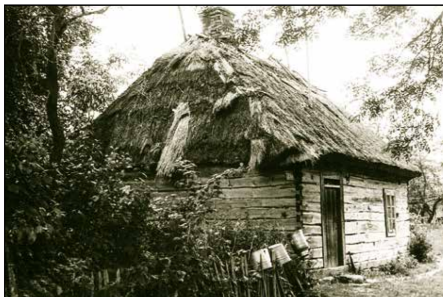
Dom drewniany ■ w Kramkowie Lipskim - wybudowany na początku XX w.
