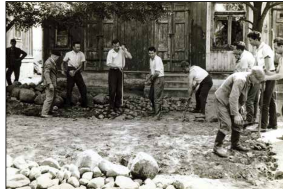
■ Budowa nawierzchni brukowcowej w Nurze w czynie społecznym - 1968 rok
