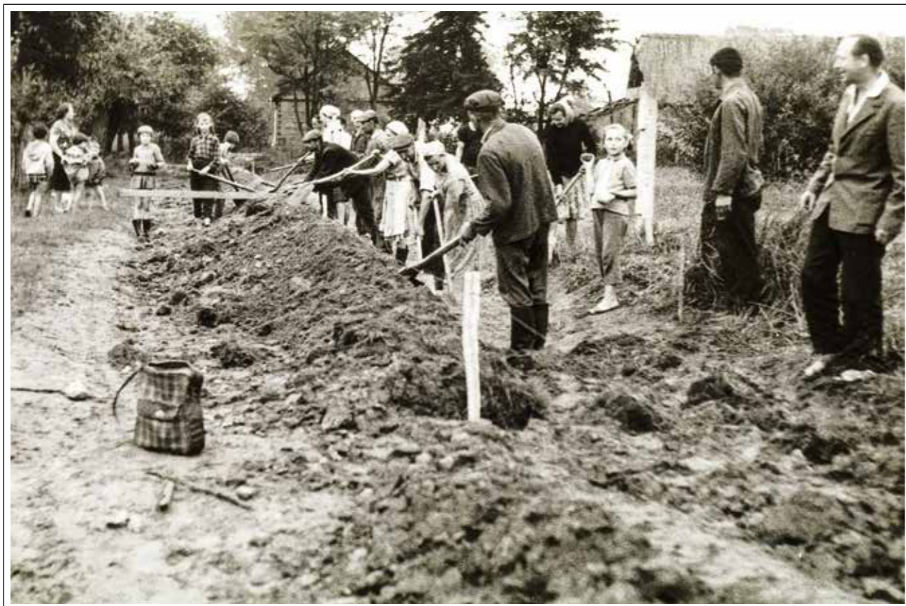
■ Czyn społeczny. Budowa ulicy Zapłotniej (obecna Łomżyńska) w Nurze - 1966 rok
