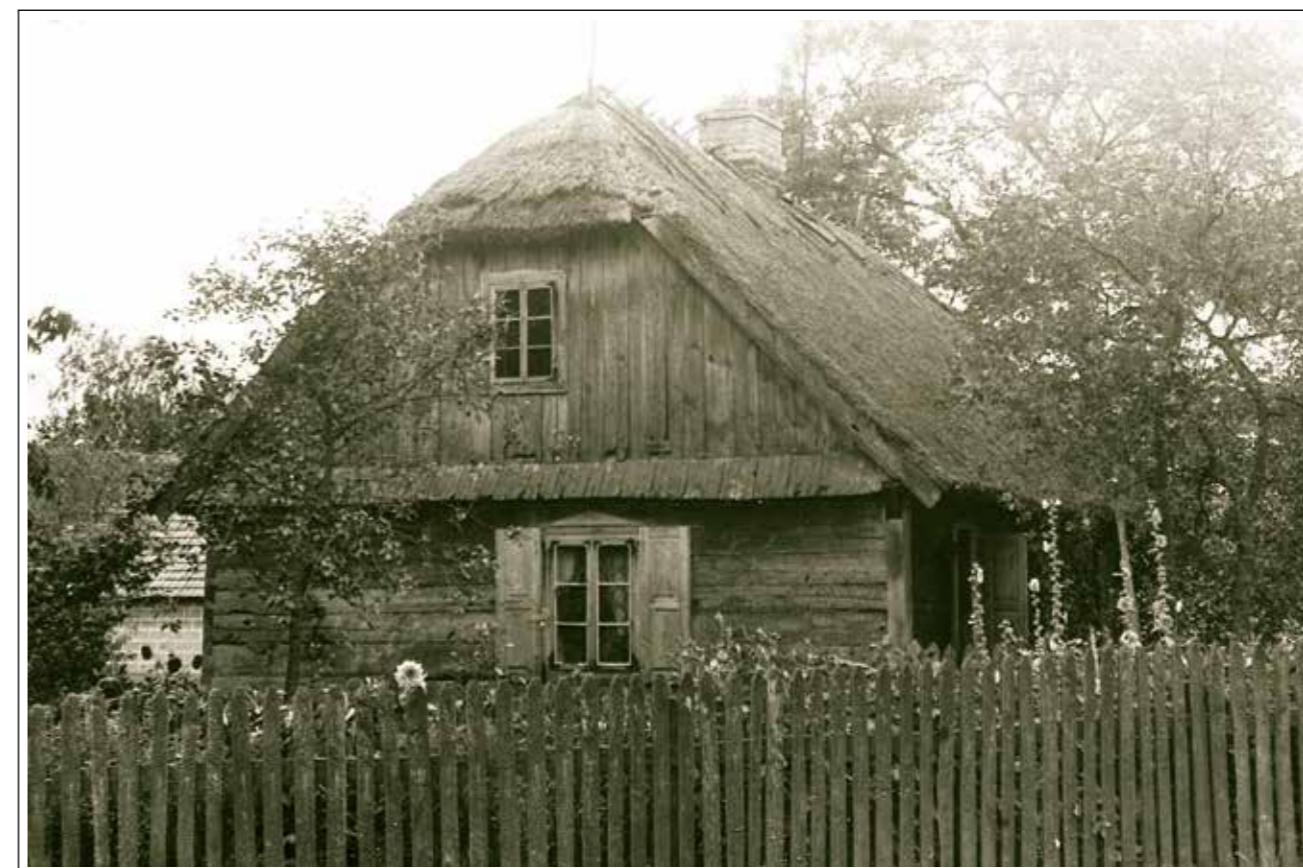
■ Dom drewniany w Kałęczynie - wybudowany w 1900 roku
