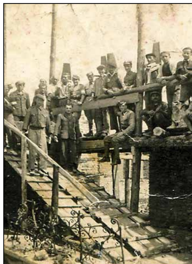
■ Odbudowa kościoła w Nurze - początek lat 50-tych
